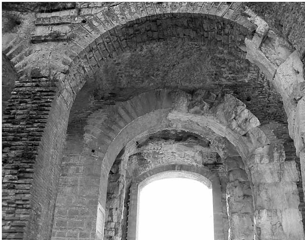
Fig. 4. Intervento di Pietro Bianchi in corrispondenza dell'ingresso meridionale dell'anfiteatro. L'intervento è documentato nella Descrizione de' lavori di fabbriche eseguite dall'appaltatore D. Giuseppe dell'Aquila per le urgenti riparazioni delle antiche fabbriche e nettamente generale colla estirpazione delle erbe cresciute di spine e cespugli nell'anno 1838 , ASSAN, VI, D1,1.
